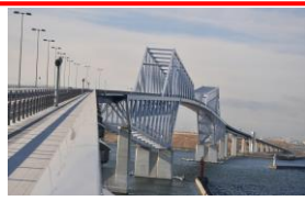
東京ゲートブリッジ
